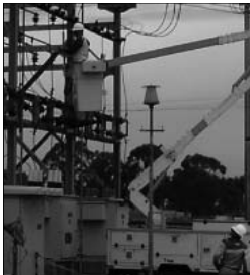
Figura 1. Ilustração. O trabalhador visto na parte superior encontra-se em zona de risco, o situado na parte inferior encontra-se em zona controlada.
