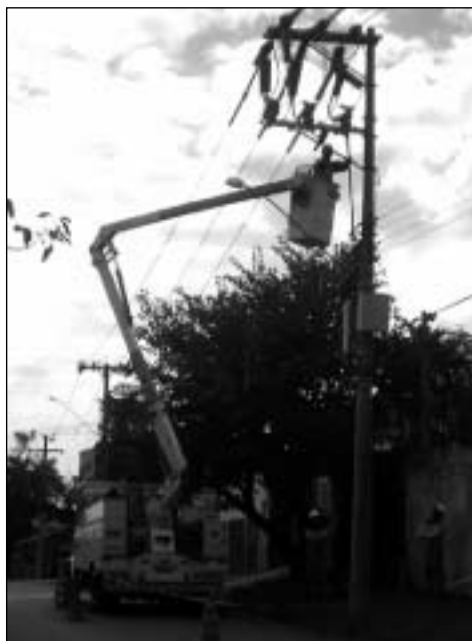
Figura 2. Ilustração. O trabalhador visto na parte superior encontra-se em zona de risco, os situados na parte inferior encontram-se em zona livre.
